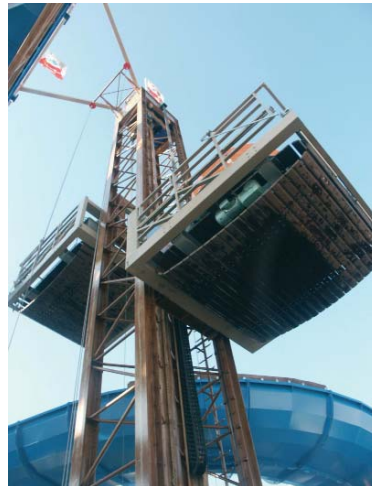
Bild FA0906-07: igus GmbH, Köln Während eine Aufzugsplattform mit Gondel nach oben fährt, kommt die zweite nach unten. Das konfektionierte Energiekettensystem schützt und führt den Strom für die hölzernen Transportbänder der Plattformen.
