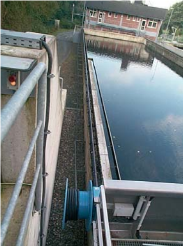
Bild FA0206-02: igus GmbH, Köln Die Ausgangssituation: Eine Kabeltrommel übernahm die Energiezuführung zum Räumler des Nachklärbeckens
