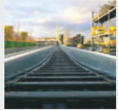
Prüfplatz - 125 m langer Verfahweg, 300 m/min Verfahrgeschwindigkeit
