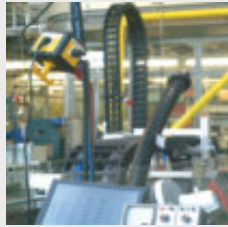
Kabelprüfung auch auf Torsion
