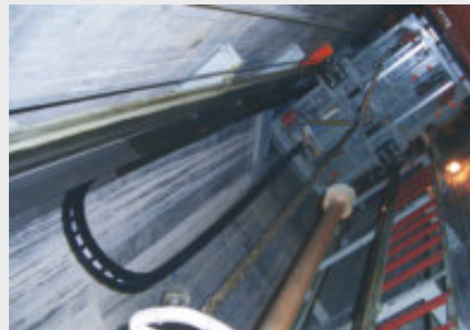
E2/000 - Stabilität auch bei ständigen Luftzug und Pendelbewegungen in diesem 160 m hohen Aufzug
