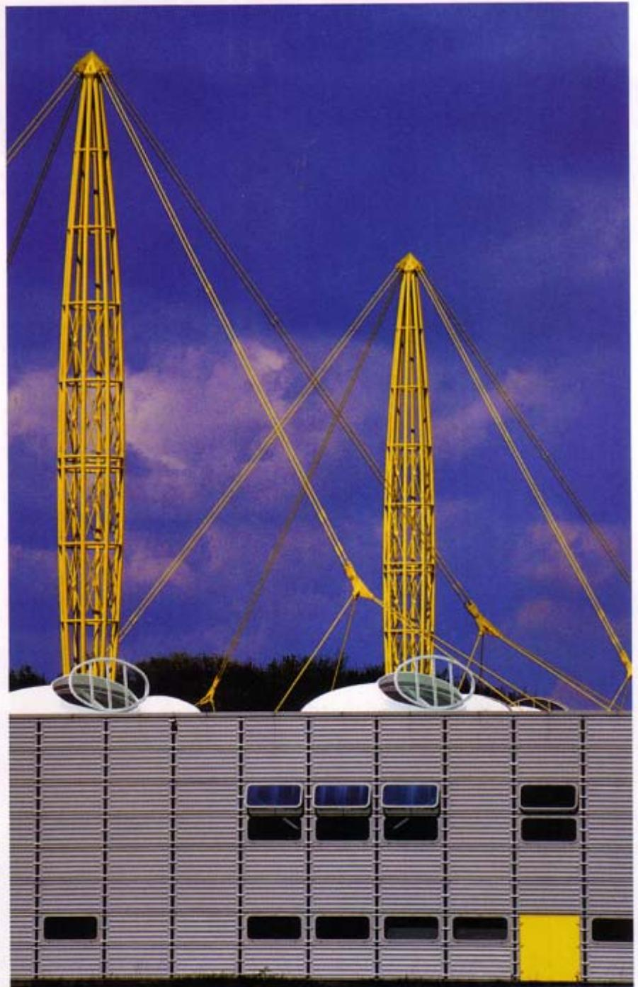
Der Kölner Hauptsitz von igus besitzt Industriecharakter. Gelbe Pylone scheinen wie durch das Dach zu schießen und bilden die Tragstruktur des Gebäudes. Fotos (2): igus
